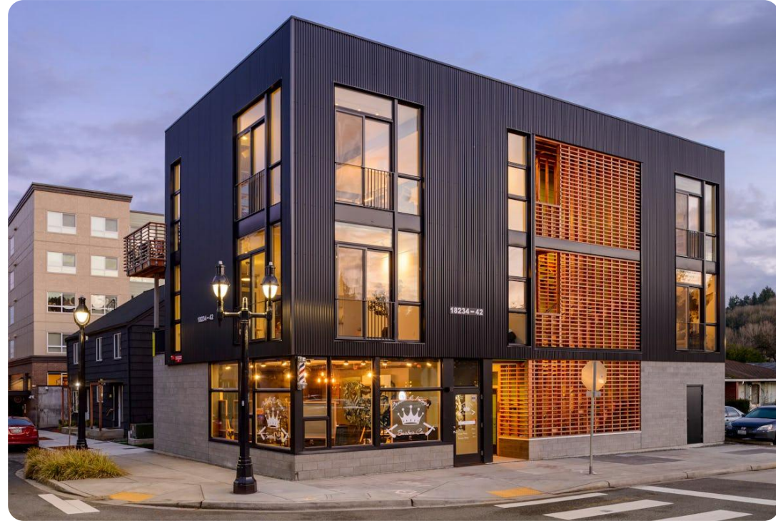
Fir Street Flats Bothell, WA
